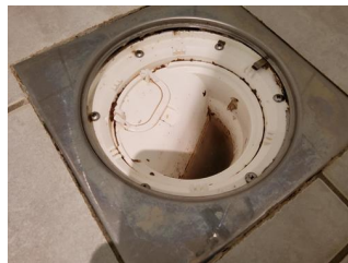
Tettesjiktets tilslutning til sluk - Sluk
