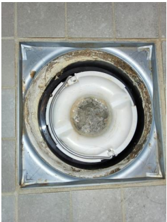
Tettesjiktets tilslutning til sluk - Sluk
