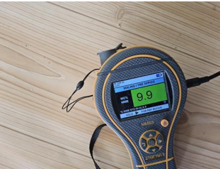
Overflate gulv - Fuktmåling i gulv under oppvaskkum.
