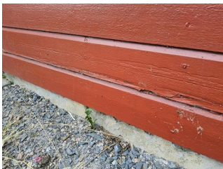
Ytterkledning (fasademateriale, vannbord, utvendig listverk, o.l.) - Tegn på råde i kledning
