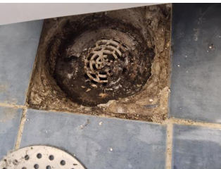
Tettesjiktets tilslutning til sluk - Sluk, membran er ikke klemt med klemring.
