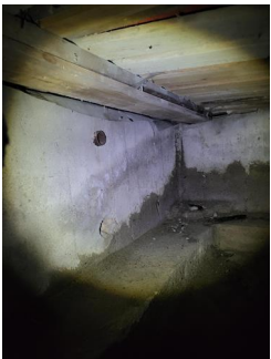
Tilsig av vann og fuktsperre mot grunn - Fuktmerker på grunnmur og salt kalkutslag
