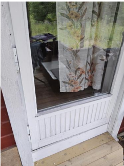
Ytterdører og omramming - Slitasje av terrassedør
