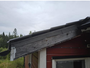
Vannbord, vindskier, gesimskasser og lignende - Stedvis manglende vindskier
