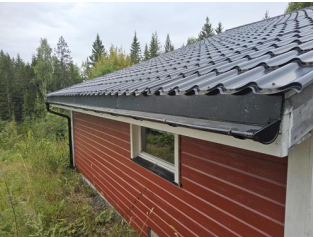
Takrenner og utvendige nedløp - Nedbøy takrenne
