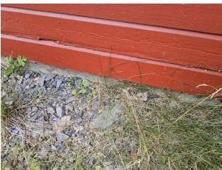
Ytterkledning (fasademateriale, vannbord, utvendig listverk, o.l.) - Kort avstand til terreng
