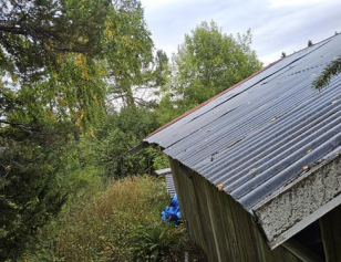
Yttertak og takkonstruksjon - -
