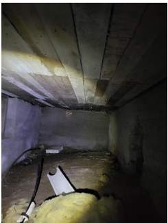
Tilsig av vann og fuktsperre mot grunn - Fuktmerker på murer og salt kalkutslag
