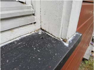
Vinduer og omramming - Tett utførelse til blikk
