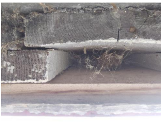
Ytterkledning (fasademateriale, vannbord, utvendig listverk, o.l.) - Kledd utenpå gammel kledning
