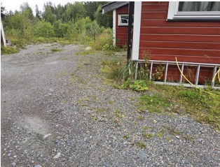
Terrengfall fra grunnmur - -
