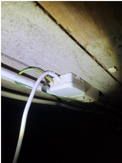
Varmtvannsbereder - VVB er direkte koblet
