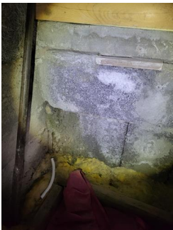
Tilsig av vann og fuktsperre mot grunn - Fuktmerker på grunnmurermurer og salt kalkutslag
