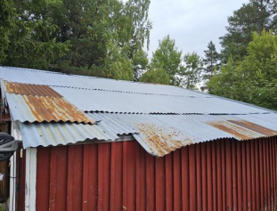
Yttertak og takkonstruksjon - -
