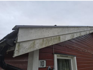
Vannbord, vindskier, gesimskasser og lignende - tegn på slitasje
