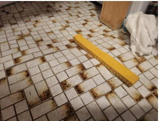
Overflater gulv - Kul på gulv.
