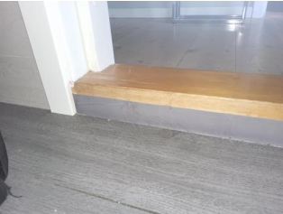
Lekkasjesikkerhet - Membranoppkant ved dørterskel.
