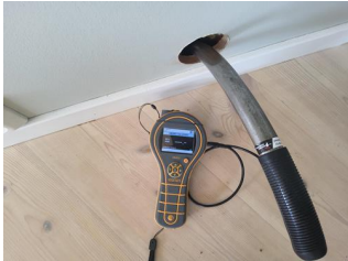
Utført kontroll i tiliggende konstruksjon - .
