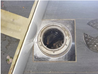
Avløp (inkl. sluk) - Sluk under badekar.
