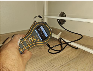
Utført kontroll i tilliggende konstruksjon - Fuktmåling bad
