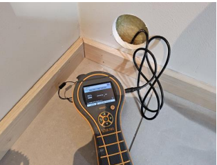
Utført kontroll i tilliggende konstruksjon - Fuktmåling vaskerom
