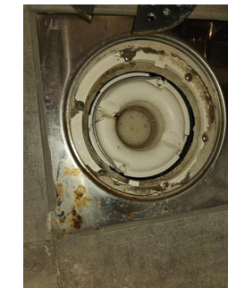
Avløp (inkl. sluk) - Hjelpesluk under badekar
