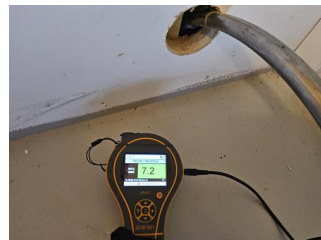
Kontroll i lukkede konstruksjoner - Fuktmåling i utlektet kjellervegg
