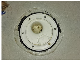
Avløp (inkl. sluk) - Sluk teknisk rom
