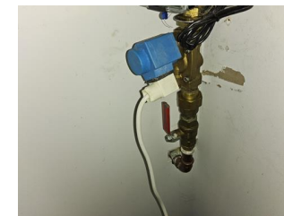
Vannrør (utover det som nevnes under andre sjekkpunkter) - Vanninntaksrør med hovedstoppekran
