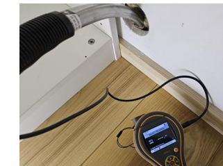
Utført kontroll i tilliggende konstruksjon - Fuktmåling bad 2.etasje
