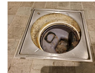
Tettesjiktets tilslutning til sluk - Sluk
