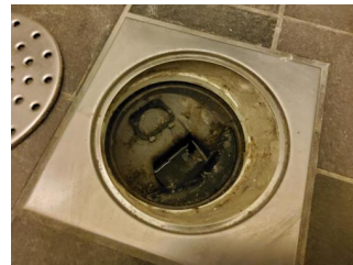
Tettesjiktets tilslutning til sluk - Sluk
