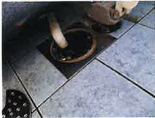
Tettesjiktets tilslutning til sluk - Sluk
