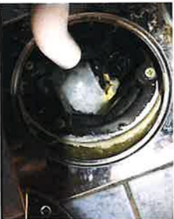
Tettesjiktets tilslutning til sluk - Sluk
