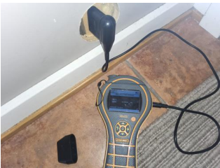
Utført kontroll i tilliggende konstruksjon - .
