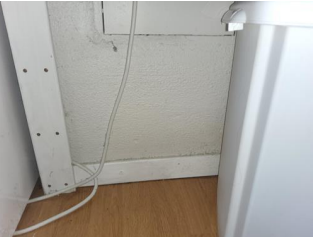
Skorsteiner inne i boligen - Sotluke.
