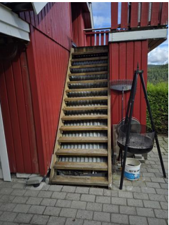
Rekkerkshøyde og lysåpninger - Trapp til loft i garasje.
