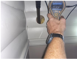
Utført kontroll i tilliggende konstruksjon - .
