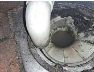
Avløp (inkl. sluk) - Sluk.
