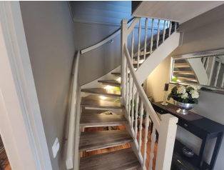
Rekkverk og håndløper - Innvendig trapp.
