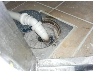
Avløp (inkl. sluk) - Sluk.
