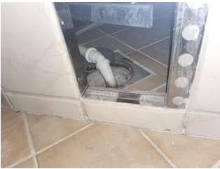
Plassering av sluk og avrenningsmuligheter - Slukets plassering under badekar.
