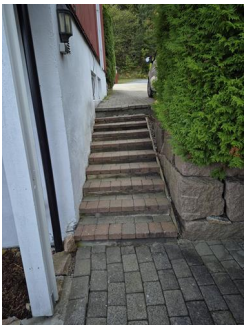
Utvendig trapp - Utvendig trapp.
