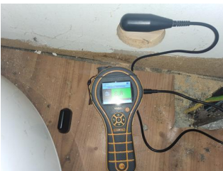
Utført kontroll i tilliggende konstruksjon - .
