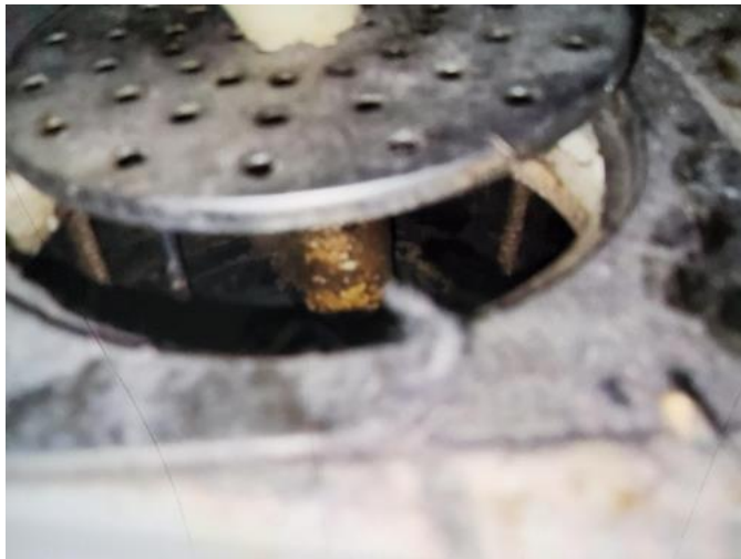
Våtrom - [Sluk på bad 2.etg ]
