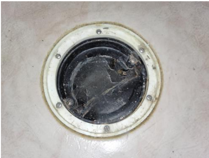
Våtrom - [Sluk på vaskerommet ]
