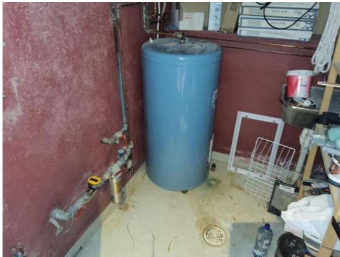
Tekniske anlegg, VVS anlegg (Sjekkpunkter utover det som er inkludert i andre rom) - [Stoppekran, vannmåler, varmekabler og sluk. ]
