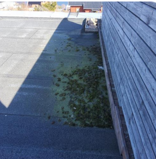
Sluk, innvendige nedløp og fallforhold på flate tak - Spor etter vannansamling på tak
