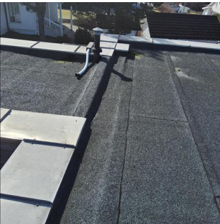
Takkonstruksjon - Varerør/elektrikkerrør
