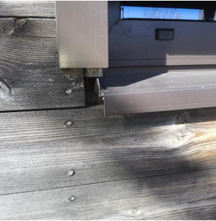
Vinduer og omramming - Eksempel på åpning i konstruksjonen ved badevindu 2.etasje
