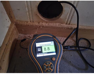
Utført kontroll i tilliggende konstruksjon - Fuktmåling vaskerom
