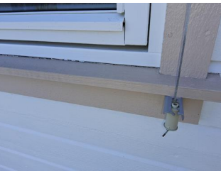
Vinduer og omramming - Eksempel på manglende vannbrettbeslag under vindu
