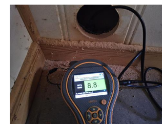
Utført kontroll i tilliggende konstruksjon - Fuktmåling vaskerom
