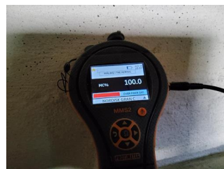
Stikktaking i treverk, fukt og fuktmålinger - Fuktmåling
