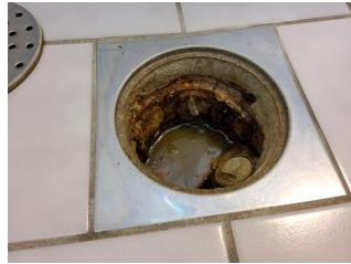
Tettesjiktets tilslutning til sluk - Sluk
