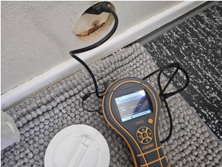
Utført kontroll i tilleggende konstruksjon - Fuktmåling bad
