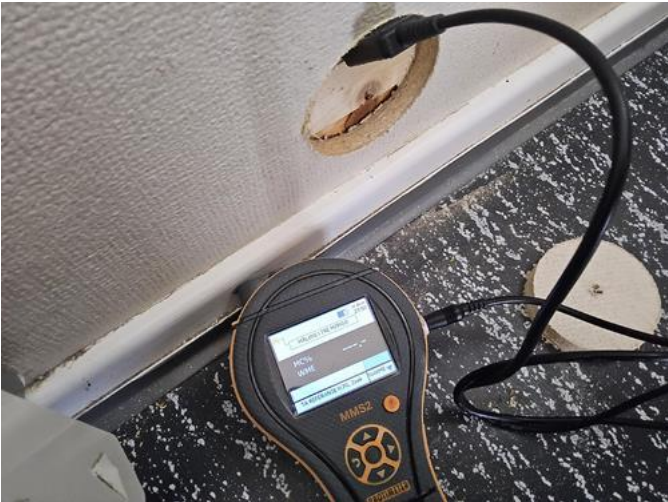
Våtrom - [Fuktmåling bad]
