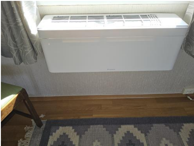
Tekniske anlegg, VVS anlegg (Sjekkpunkter utover det som er inkludert i andre rom) - [Luft til luft varmepumpe]
