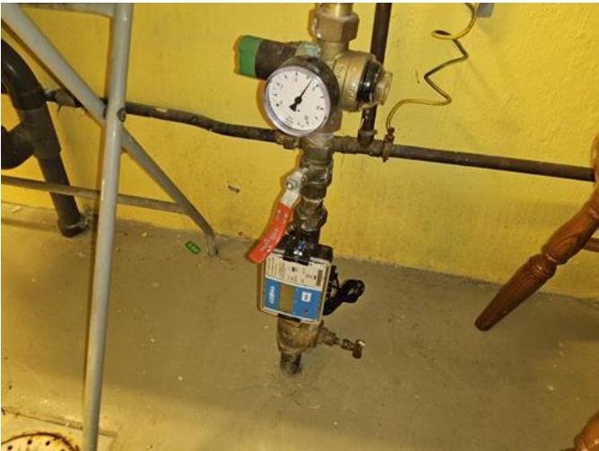
Tekniske anlegg, VVS anlegg (Sjekkpunkter utover det som er inkludert i andre rom) - [Vanninntaksrør med hovedstoppekran ]
