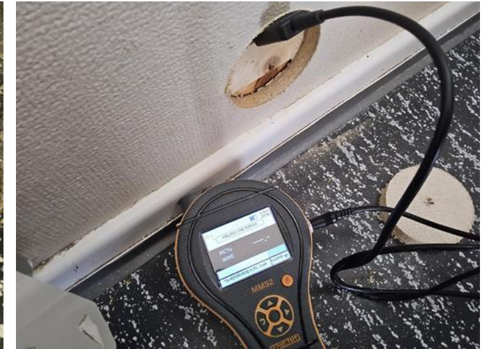
Våtrom - [Fuktmåling bad]
