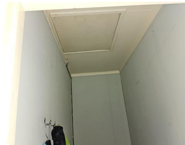
Loft - uinnredet / råloft - [Luke til loft i trapperom]
