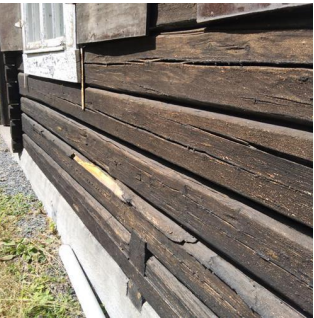
Helhetsvurdering - Eksempel på slitasjer
