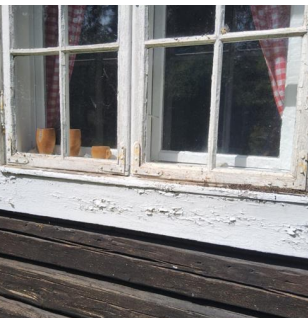
Helhetsvurdering - Eksempel på slitasjer
