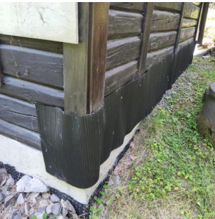
Helhetsvurdering - Eksempel på tildekket tømmer
